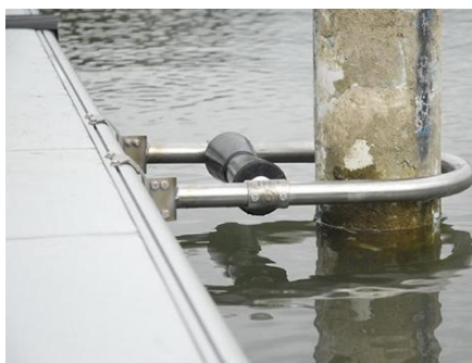
Figure 5 : Etriers sur pieux battus
